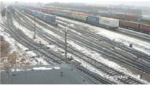
Infrastruktura spółki CARGOTOR na stacji Kobylany obsługującej kolejowe przejście graniczne Brześć – Terespol po szerokim, wschodnim torze o prześwicie 1520 mm
