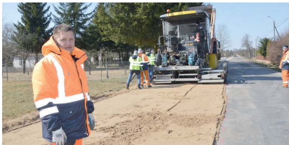
- Roboty realizowane są zgodnie z harmonogramami przedłożonymi przez poszczególnych wykonawców - zapewnia starostwo. Są wykonywane na trzech odcinkach dróg powiatowych o różnej długości - od ok. 7 km do ok. 11 km. Na fotografii - prace w Branicy Radzyńskiej Kolonii
