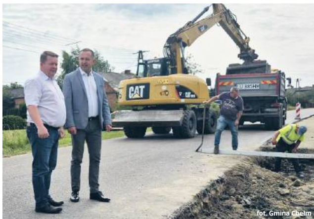
Prace drogowe w Horodyszczu
