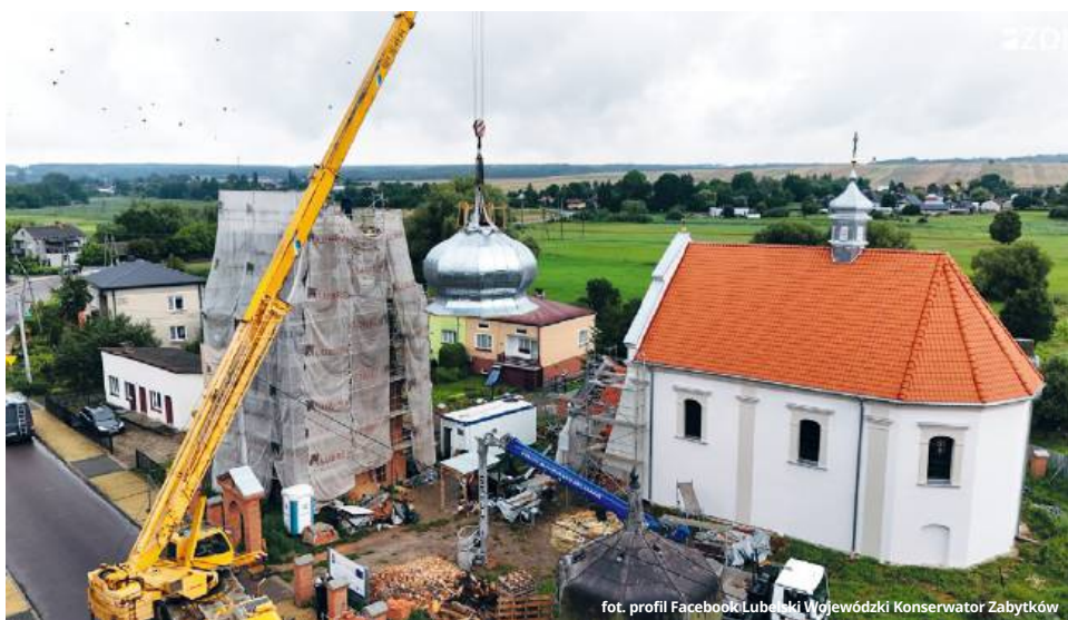
Kopułę dzwonnicy umieszczono już na właściwym miejscu
