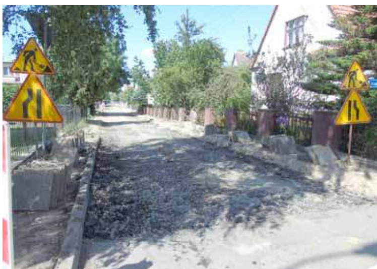
Od tygodnia na terenie objętym przebudową nie zadziało się nic oprócz zerwania starej nawierzchni drogi
