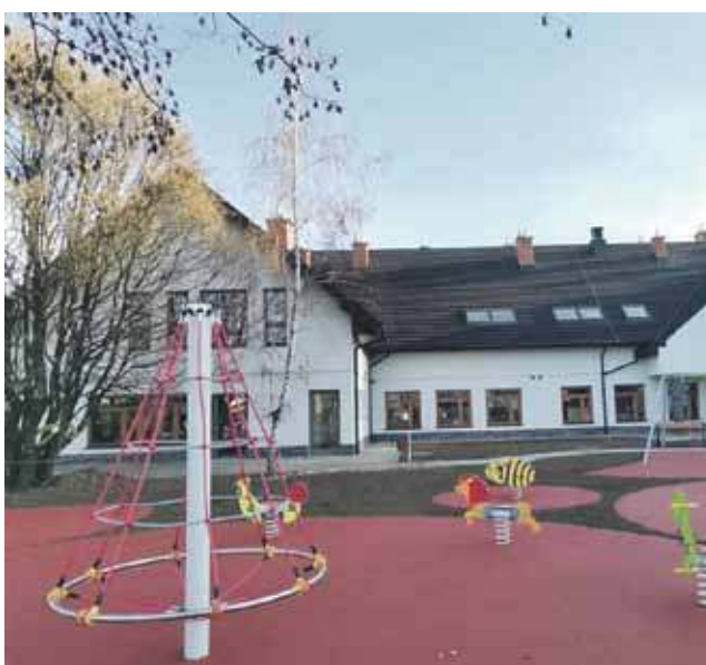
Żłobek już prawie gotowy, teraz wewnątrz obiektu trwają prace wykończeniowe.
