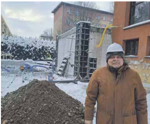
Grzegorz Ratter obok miejsca, gdzie stanie kogenerator.
