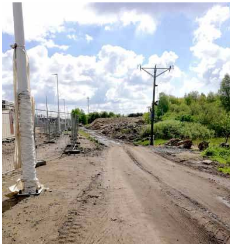
W tym miejscu powstanie punkt przesiadkowy w Reptowie – kilka tygodni temu został przekazany plac budowy wykonawcy inwestycji
