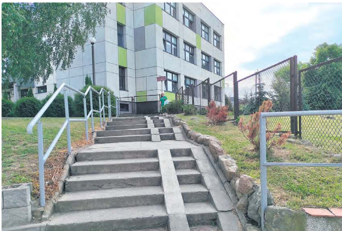
Budowa przejścia będzie wiązała się też z przebudową schodów. Fot. (kt)
