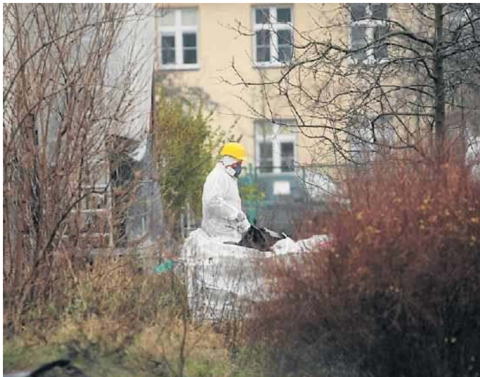
Za usuwanie eternitu nie powinniśmy zabierać się sami. Może to zrobić jedynie specjalistyczna firma, która posiada uprawnienia, odpowiedni sprzęt i przeszkolonych pracowników
