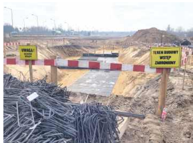
Wykopy pod fundamenty obiektów mostowych
