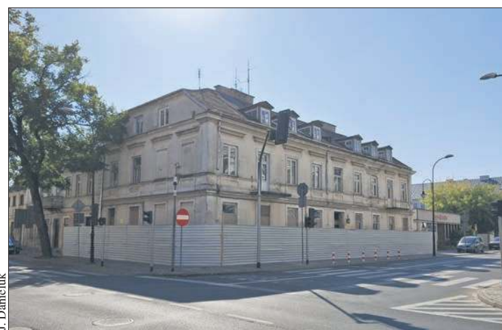
Budynek przy ul. 1 Maja 2 zostanie wyburzony. W jego miejsce powstanie nowy obiekt
