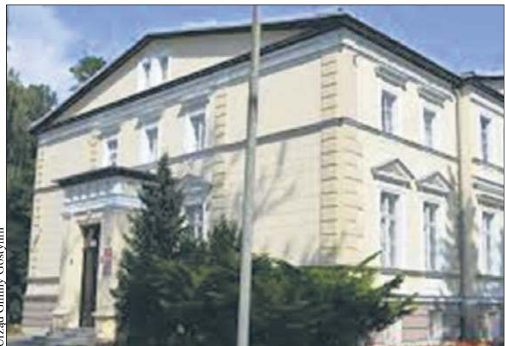
Zabytkowy obiekt pałacowy w Lucieniu potrzebuje systematycznie remontów i napraw
