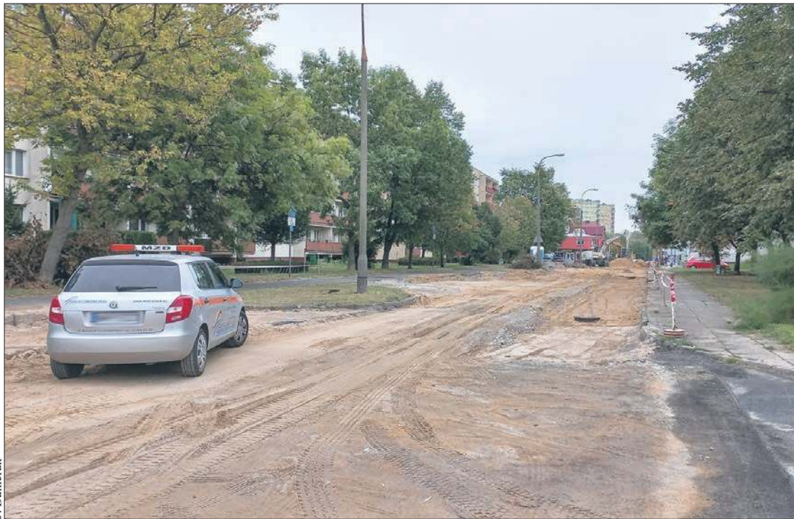
Przebudowa fragmentu ulicy Lasockiego potrwa 5 miesięcy
