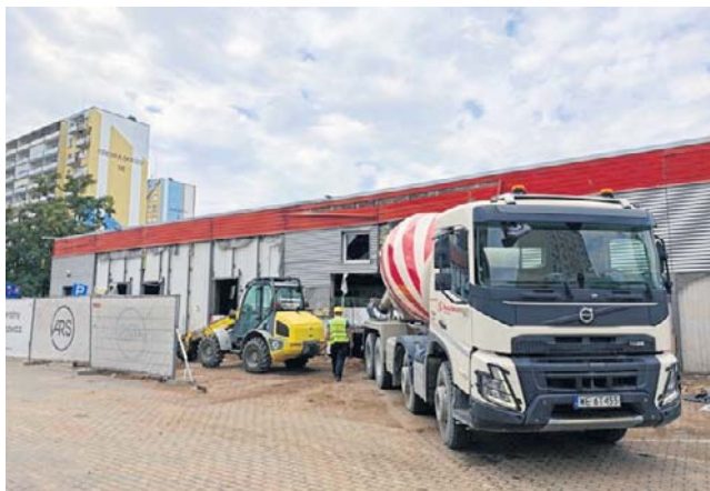
Przebudowa sklepu sieci Torimpex Trade przy ulicy Dziewulskiego 23 rozpoczęła się 22 lipca
