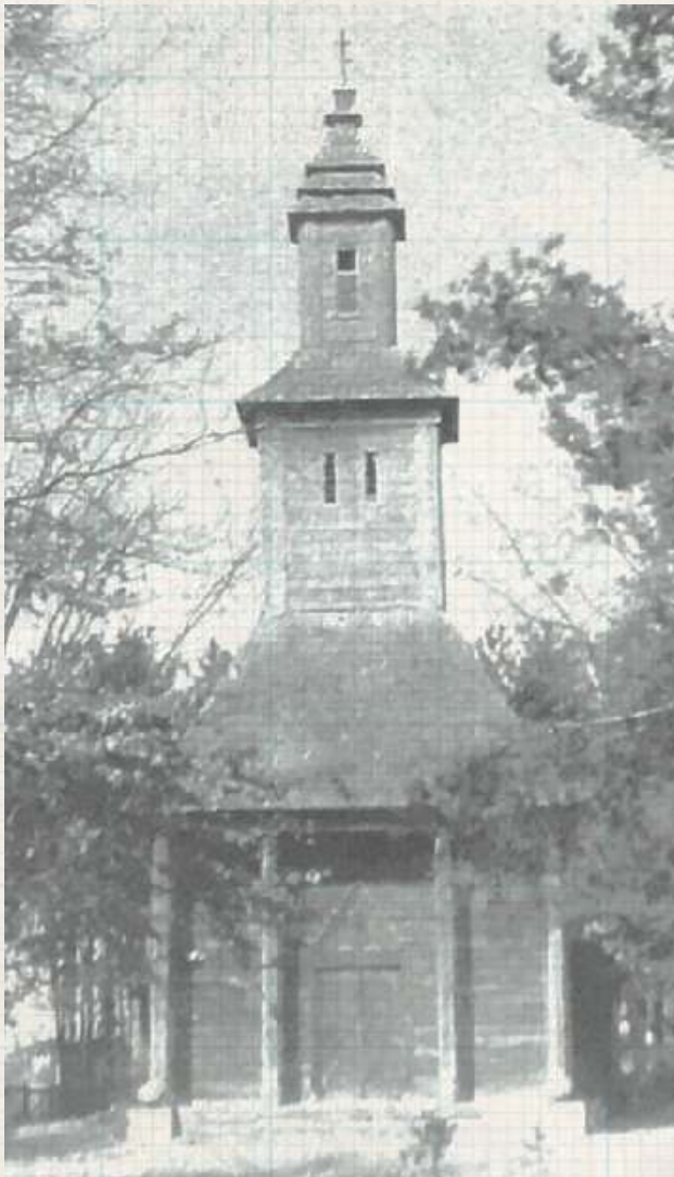
W osi nekropolii na Łapiguzie wybudowano drewnianą kaplicę, wyróżniającą się smukłą wieżą nad przedsionkiem. We wnętrzu na boazerii wypisane były wszystkie nazwiska pochowanych w jej cieniu wojaków.
