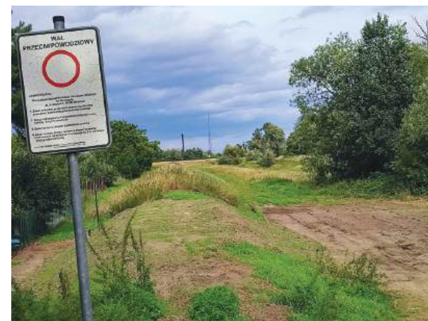
Prace związane z odbudową wału przeciwpowodziowego zostały zakończone
