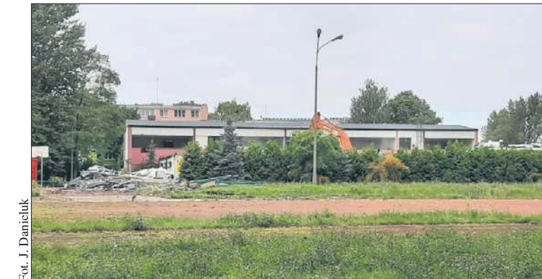
Rozpoczęła się rozbiora dawnego budynku „Siedemnastki”. W tym miejscu powstanie aquapark
