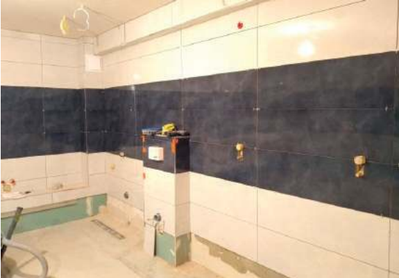
Na takim etapie były prace wykończeniowe w łaźni na koniec października
