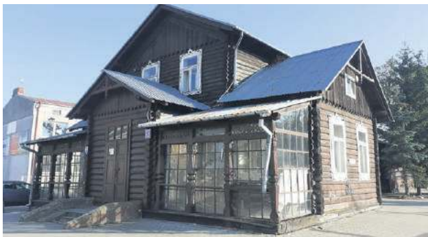
Banery szpeczące elewację usunięto.
