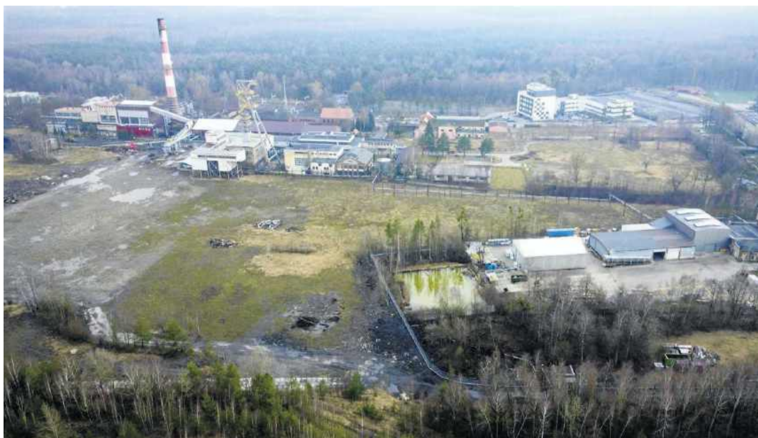
• Zamknięta kopalnia Boże Dary FOT. SRK
