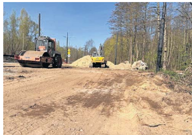
Na realizację przebudowy torowiska na ul. Toruńskiej dofinansowanie z Funduszy Europejskich dla Kujaw i Pomorza 2021-2027 to 34,3 mln zł oraz z KPO - 48,04 mln zł
