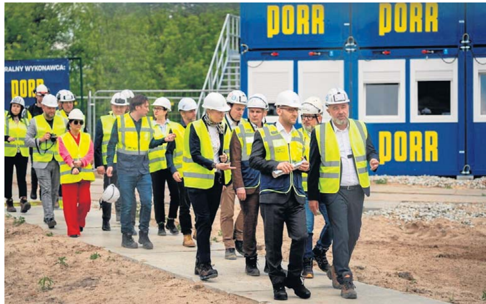
Wmurowanie kamienia węgielnego rozpoczyna kolejną fazę - wznoszenie konstrukcji
