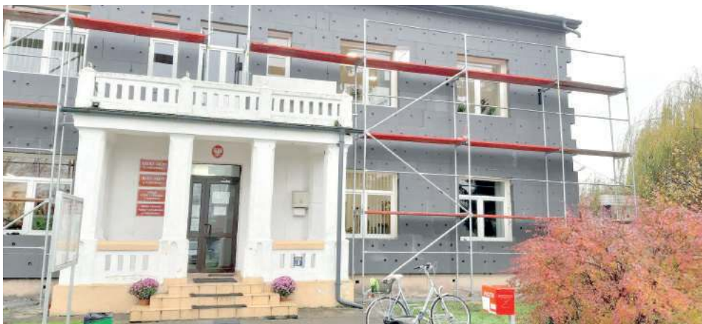
Prace ruszyły jesienią. Wymieniona została m.in. elewacja
