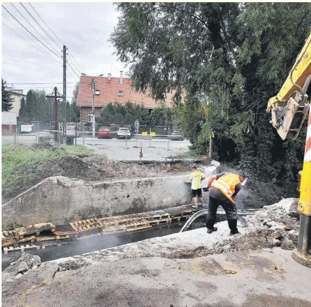
W Strzeszowie trwają prace rozbiórkowe starego mostu
