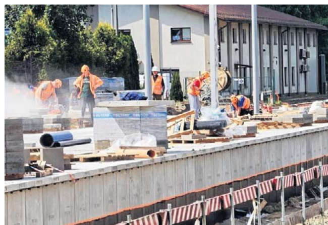
Przebudowa stacji Sosnowiec Główny
