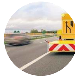
FOT. AUTOSTRADA WIELKOPOLSKA
