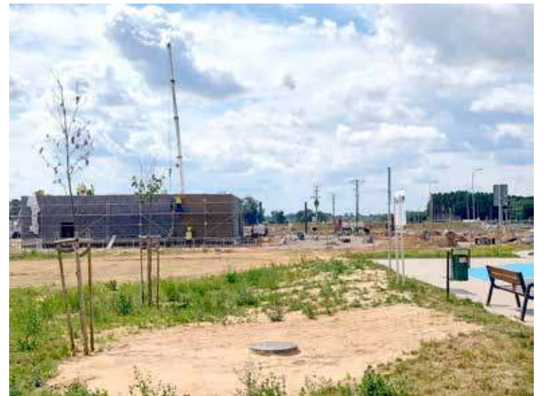
Intensywne prace przy samym MOP
