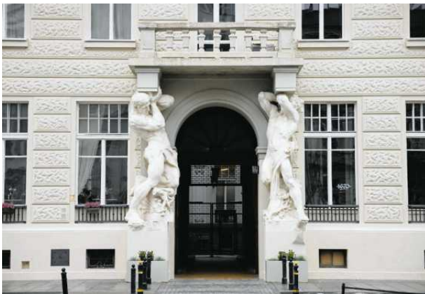
• Tak wygląda teraz fasada kamienicy „Pod Gigantami” FOT. DAWID ŻUCHOWICZ / AGENCJA WYBORCZA.PL
