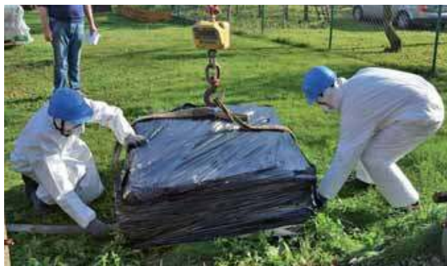
Prace związane z usuwaniem azbestu
