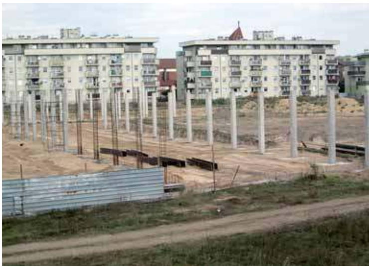
Na razie widać tylko słupy na placu budowy przyszłych obiektów
