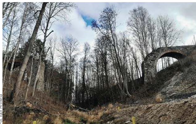
Resztki wiaduktu, którym kiedyś pociągi jeździły do Rucianego
