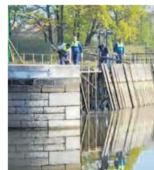
Jaz wykorzystywany jest do żeglugi turystycznej
