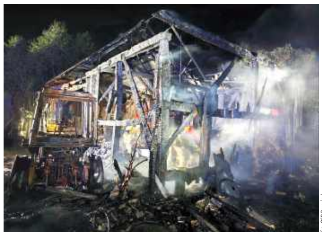
Ogień objął budynek gospodarczy, w którym znajdował się sprzęt rolniczy oraz wyposażenie gospodarstwa. Zagrożony był również znajdujący się w bezpośrednim sąsiedztwie budynek mieszkalny
