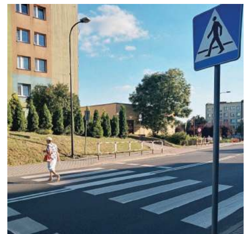
Doświetlone będzie m.in. przejście dla pieszych na ul. Traugutta, tuż obok MOK
