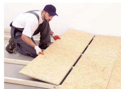
🔧 Suchy jastrych można wykonać z płyt drewnopodobnych. KRONOPOL
