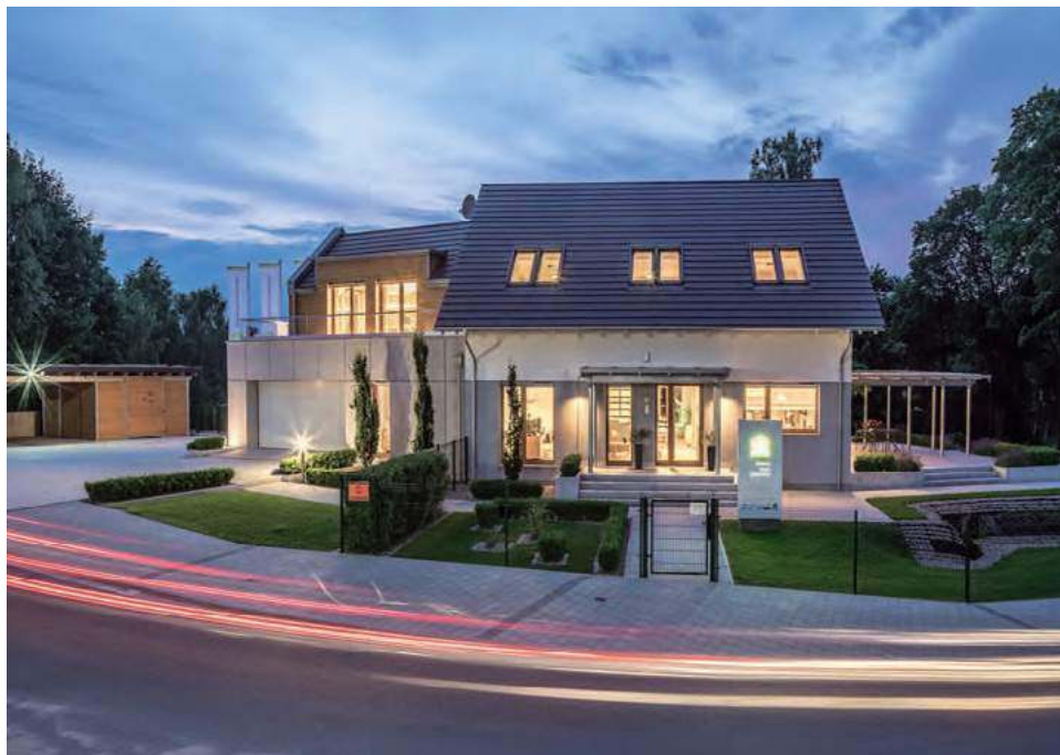
👉 Bardzo nowoczesny dom z drewnianych prefabrykatów – pasywny, ogrzewany gruntową pompą ciepła (nie ma kominów!). BRAWO DOMY PASYWNE/MULTICOMFORT SAINT-GOBAIN
