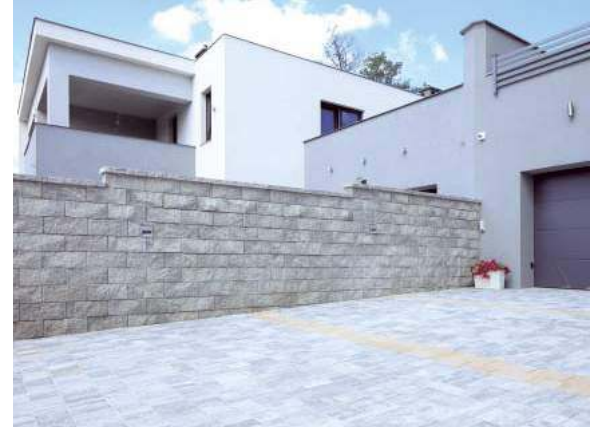
🔑 Murowane ogrodzenie wykonane ze bloczków betonowych, układanych na podmurówce z żelbetu z szalunkiem i zbrojeniem. Bloczki oferowane są w kilku kolorach, ułatwiających dopasowanie wyglądu ogrodzenia do elewacji budynku. POLBRUK
