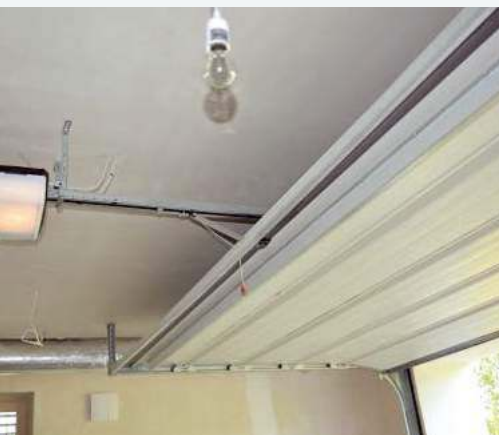
🔦 Lampa sygnalizacyjna uruchamia się wraz z włączeniem napędu.
