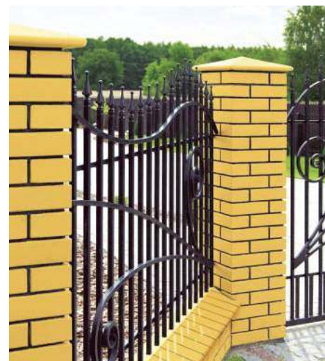
🔑 Klinkier najczęściej wykorzystywany jest do murowania słupków ogrodzeniowych. KING KLINKER
