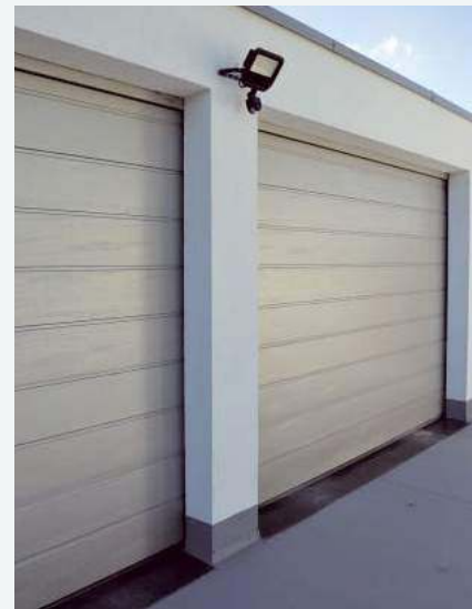
🔧 Na progu zamontowano nakładkę z blachy, jako zaporę przed wodą opadową.
