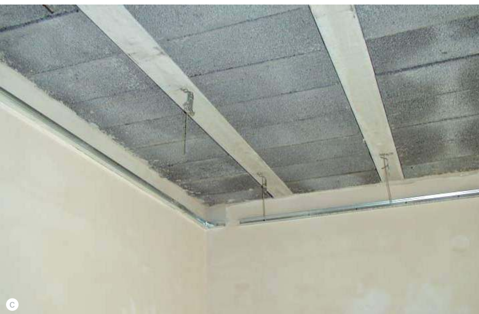
❶ Płyt gipsowo-kartonowe zastępują mokry tynk najczęściej na poddaszu (a SINIAT), w systemach lekkich ścian działowych (b KNAUF) oraz w sufitach podwieszanych (c KNAUF).
