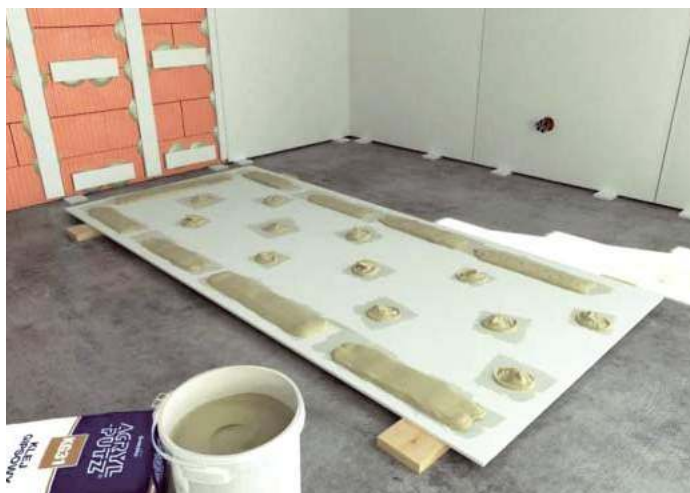
❗ Suche tynki zazwyczaj przykleja się do ścian. ŚNIEŻKA
