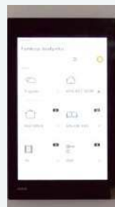
Panel centralny do sterowania systemem domu inteligentnego (w środku parteru).
