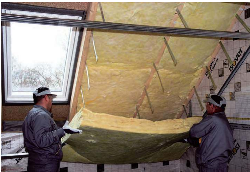
Wetną ocieplającą połąć dachu skośnego układa się przynajmniej w dwóch warstwach. Przy jednej krokwie staną się mostkami termicznymi. ISOVER
