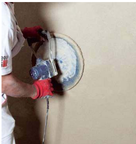
❶ Przed całkowitym wyschnięciem powłoki konieczne jest staranne wygładzenie powierzchni. BAUMIT
