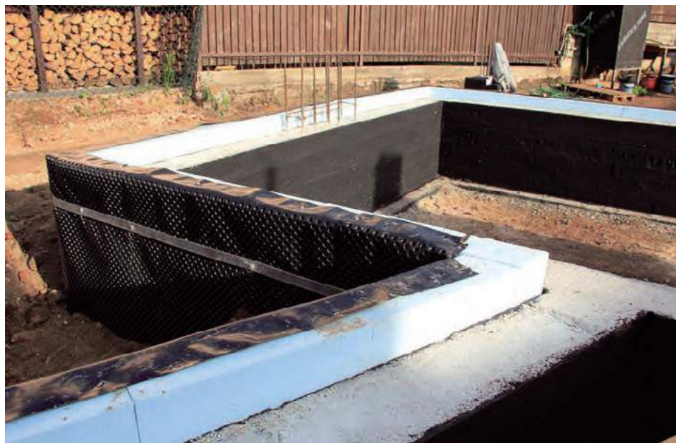
Ściany fundamentowe ocieplone od zewnątrz 15 cm niebieskiego styropianu typu fundament, zabezpieczonego folią kubelkową. J. WERNER
