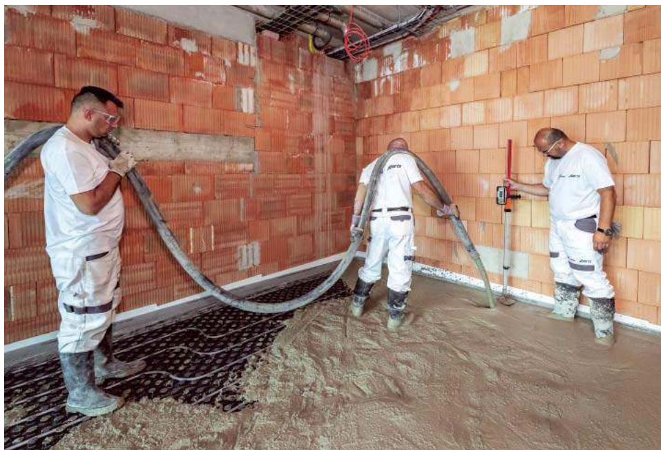
🔧 Wylewkę anhydrytową najwygodniej wylewać przy użyciu pompy. CEMEX
