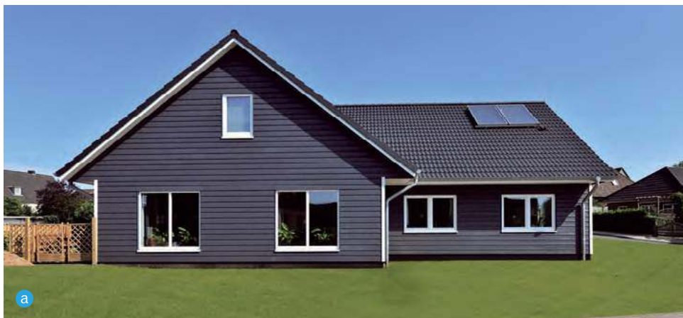
a Dachówki betonowe – dla niewprawnego oka trudne do odróżnienia od ceramicznych: falista ( a CREATON POLSKA) i płaska ( b MONIER BRAAS).
