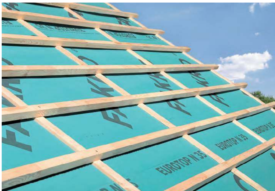
f Za szczelność dachu odpowiada także podkład, znajdujący się między więźbą i pokryciem. FAKRO
