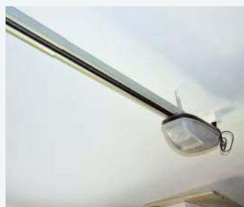
2 Pod sufitem przygotowano instalację elektryczną do napędu o sile 700 N.
