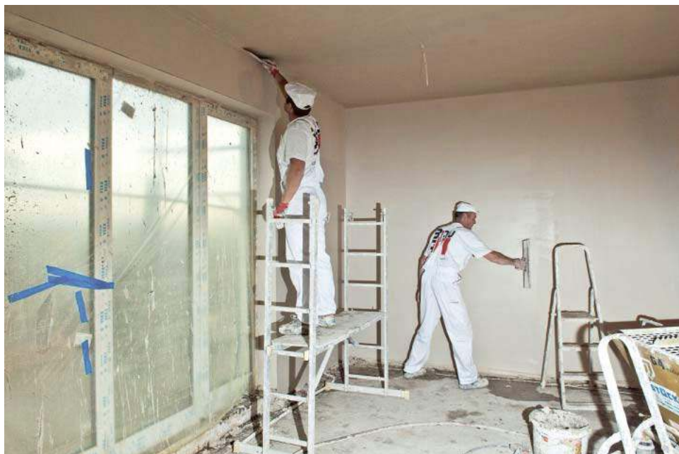
🔧 Ściany i sufity tynkuje się po ułożeniu instalacji elektrycznej. BAUMIT
