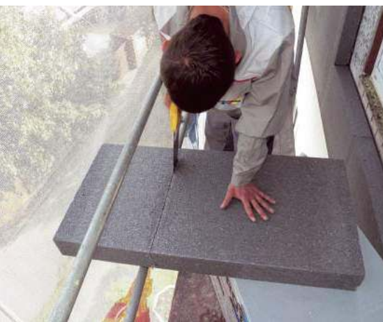
Podstawową metodą zabezpieczenia szarego styropianu przed przegrzaniem jest zacinienie elewacji. Jednak wykonawcy nie lubią rozpinać siatek na rusztowaniach. AUSTROTHERM
