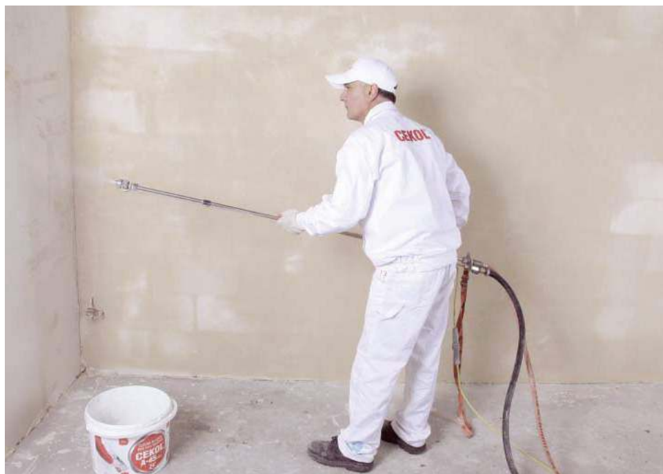
🔧 Minimalna grubość powłoki nakładanej maszynowo powinna wynosić 8 mm. CEDAT
