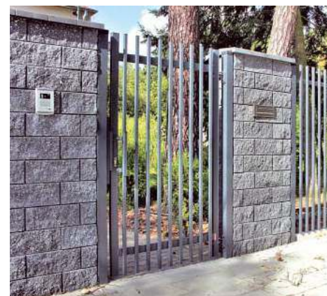
🔑 Furtka ma mieć minimum 90 cm szerokości, a domofon lub wideodomofon oraz skrzynka na listy powinny być zamontowane tuż obok. KONSORT
