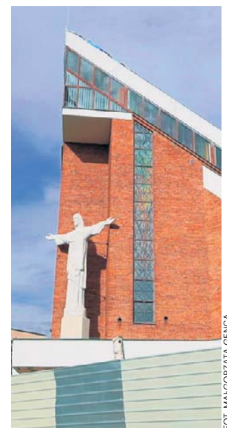
Trwają prace nad projektem przebudowy kościoła
