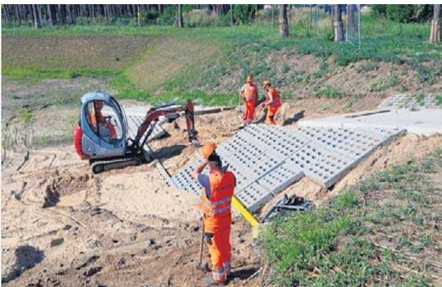
Ekipa Melbudu naprawia uszkodzoną skarpe zbiornika retencyjnego przy ul. Chełmińskiej
