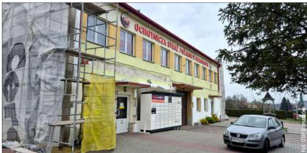
Remiza jest w trakcie termomodernizacji.
