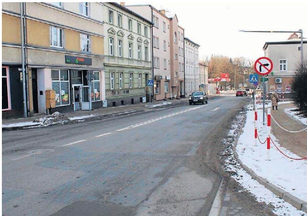
Remontem ma być objęty odcinek od ronda przy stacji paliw Orlen aż do skrzyżowania z ul. Monte Cassino. Przebudowana ma być jezdnia oraz chodniki
