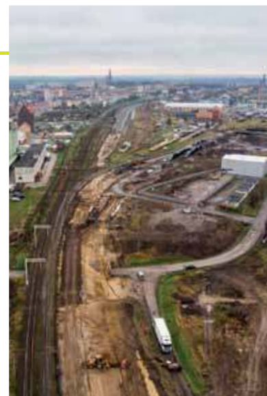
wiadukt nad ul. Składową
