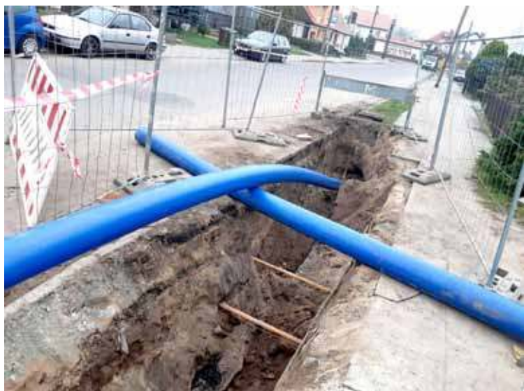
MPGK usuwa rury azbestowo-cementowe i w ich miejsce montuje rury polietylenowe
