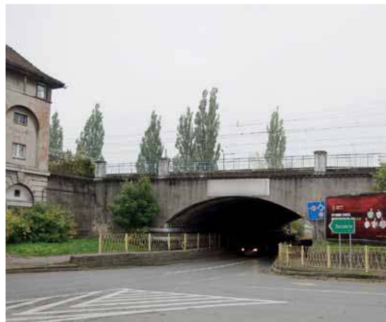
wiadukt nad ul. Ks. Bogusława IV
