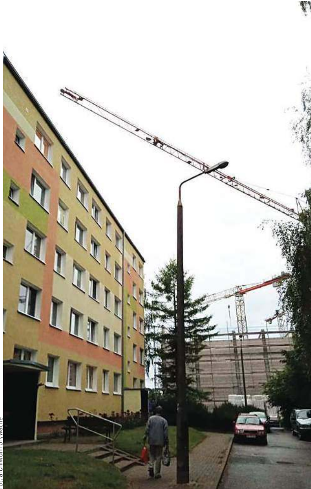
Ramię żurawia zawisło nad budynkiem przy ulicy Dworcowej w Olsztynie
