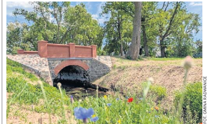
Inwestycja obejmowała remont mostu wraz z przyległym odcinkiem drogi gminnej w Kłębanowicach
