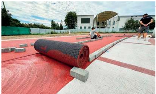
W miejscu wysłużonego stadionu powstaje nowy. Obecnie budowana jest bieżnia
