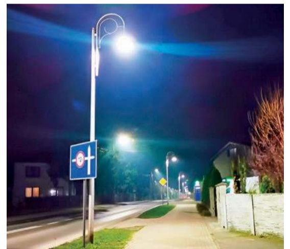
Wymieniono 83 oprawy lamp na energooszczędne
