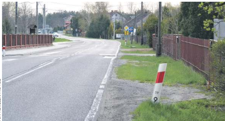
W ramach planowanej przebudowy ulica Głowackiego zostanie poszerzona do 7 metrów. Wzdłuż jezdni powstaną chodniki i ścieżka rowerowa
