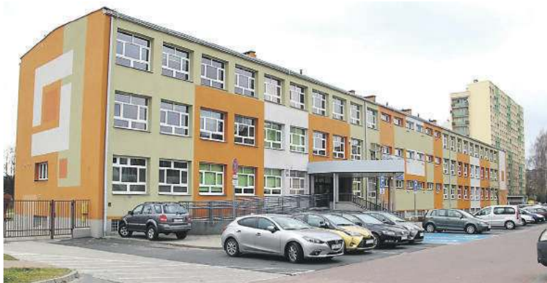
Realizowany projekt przewiduje m.in. budowę windy zewnętrznej przy PSP nr 7
