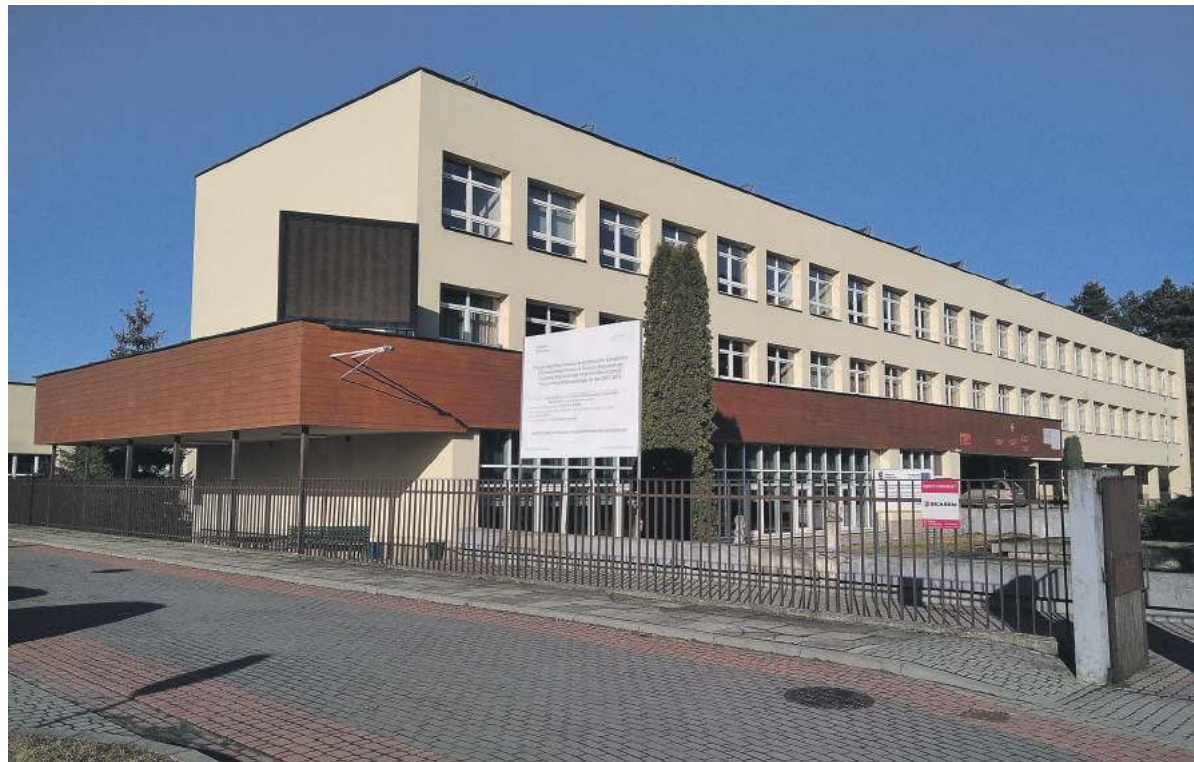
Finał prac przy przebudowie Sali gimnastycznej w CEZ planowany jest na okres powakacyjny
