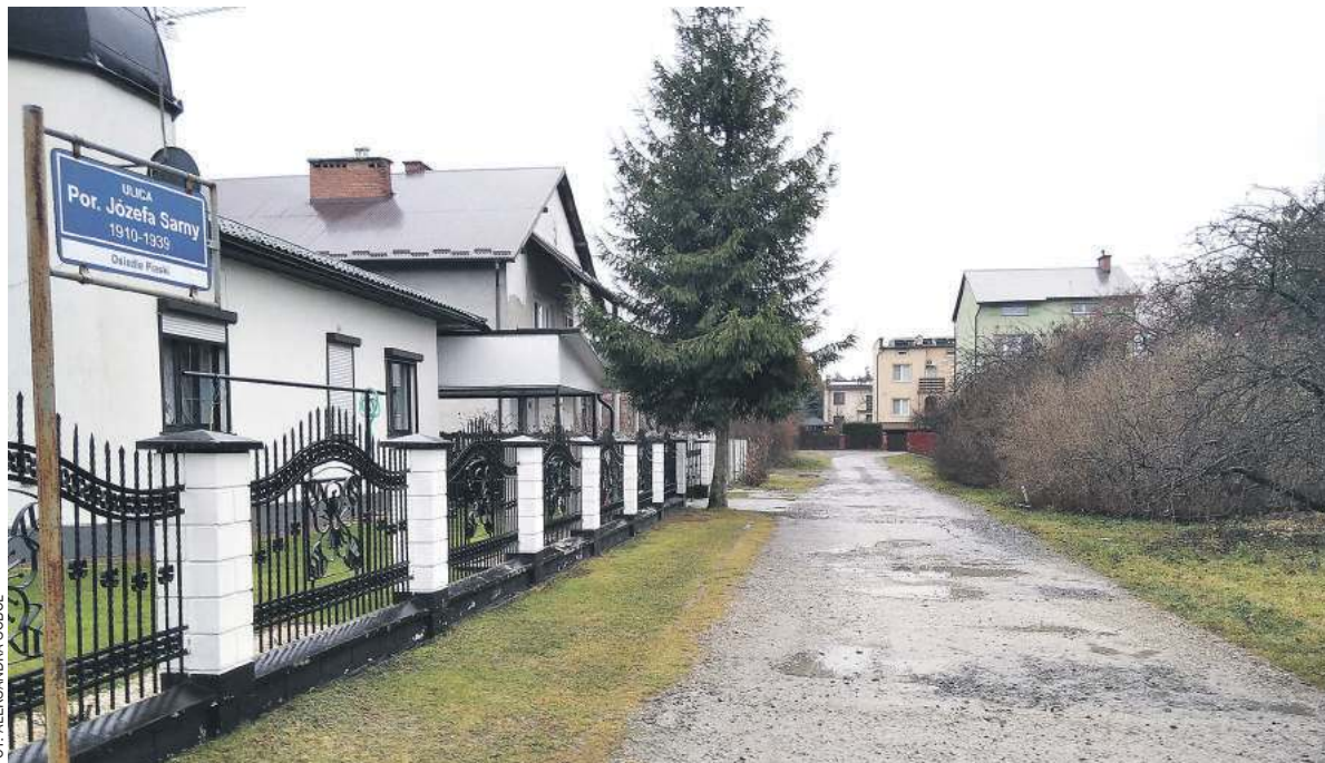
Mieszkańcy ulicy Sarny od lat czekają na budowę drogi
