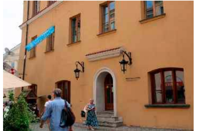
Wewnątrz Czarciej Łapy trwa generalny remont
