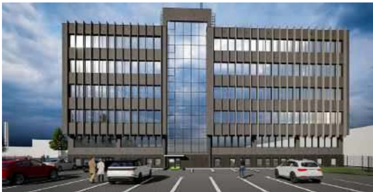
Tak będzie wyglądał budynek przy ul. Diamentowej 4 po przebudowie
