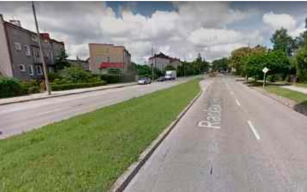
Miejski odcinek dwupasmowej ul. Racławickiej przebiega przez osiedle domków jednorodzinnych
