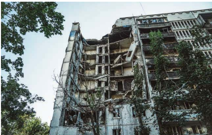
Zniszczone budynki w Saltiwce Północnej, części Charkowa, która najbardziej ucierpiała od początku rosyjskiej inwazji.
