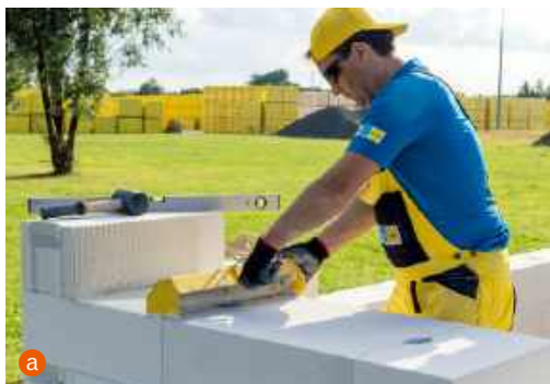
➋ Elementy murowe łączy się dziś nie tylko tradycyjnie, lecz także zaprawą do cienkich spoin (a XELLA) i poliuretanową pianą z puszk (b WIENERBERGER).
