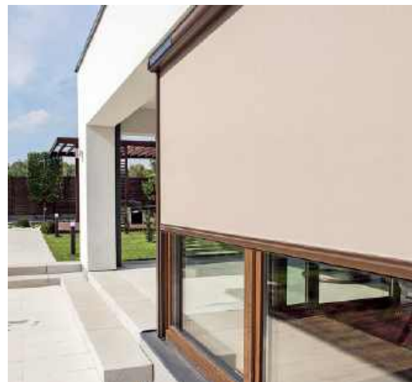
🔗 Markiza „przechwytuje” promieniowanie słoneczne przed szybą i emituje ciepło na zewnątrz. Dzięki temu wewnątrz domu nie nagrzewa się. FAKRO
