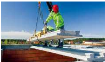
🔗 Do układania lżejszych stropów prefabrykowanych wystarczy HDS, czyli samochód ciężarowy z żurawiem. STROPY.PL
