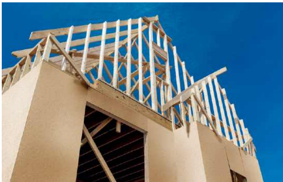
📍 Domy o konstrukcji szkieletowej są w naszym kraju znacznie mniej popularne, niż murowane. Za to drewniana więźba dachowa jest standardem w niemal każdej technologii budowy. WOODECO
