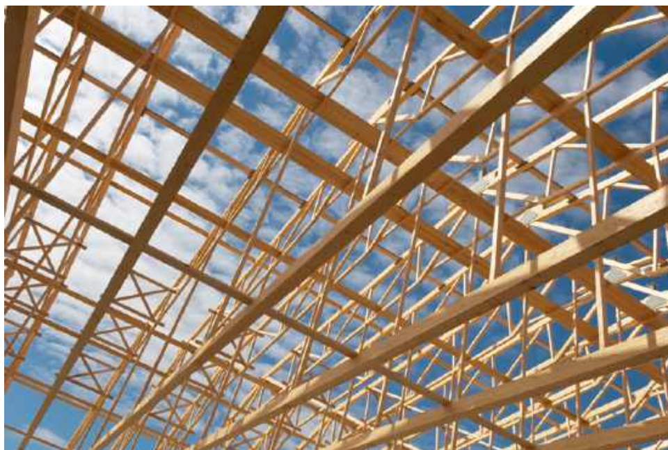
🔗 Dzięki prefabrykacji na zautomatyzowanych liniach produkcyjnych można szybko i niezwykle dokładnie wykonać nawet skomplikowane elementy konstrukcji. JAF POLSKA
