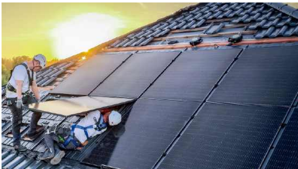
🔧 Od 2030 r. montaż instalacji przetwarzających energię słoneczną będzie na budynkach mieszkalnych obowiązkowy. CREATON POLSKA
