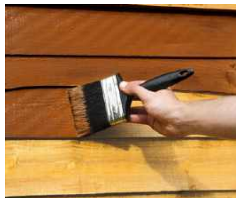
Drewno ma niezaprzeczalny urok, ale wymaga systematycznej konserwacji – impregnacji i zabezpieczania przed wilgocią, grzybami oraz promieniowaniem UV. ALTAX
