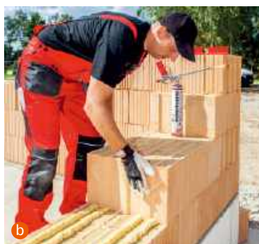
➋ Elementy murowe łączy się dziś nie tylko tradycyjnie, lecz także zaprawą do cienkich spoin (a XELLA) i poliuretanową pianą z puszk (b WIENERBERGER).
