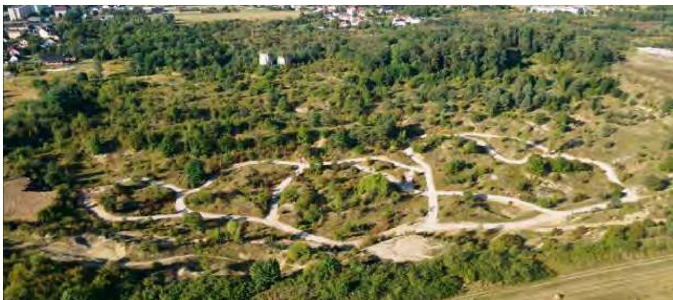
Wykonaliśmy większość prac budowlanych związanych z utworzeniem całej infrastruktury tego miejsca - mówi Krzysztof Reinert.
