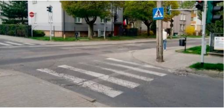
Przebudowa obejmie skrzyżowanie ul. Głowackiego z ul. Popiełuszki i jej remont na odcinku do skrzyżowania z ul. Legionową
