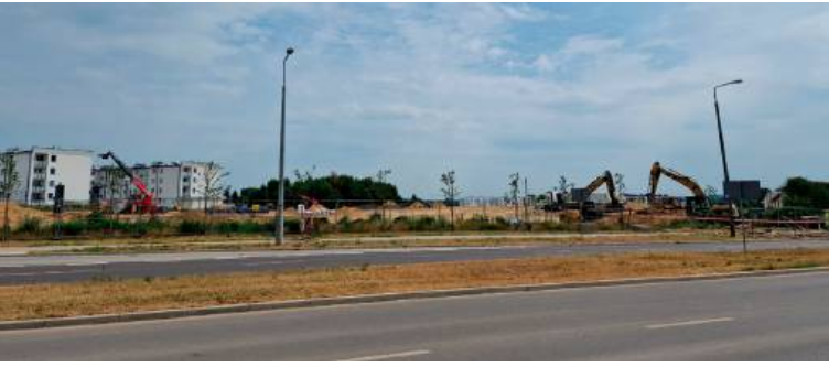
Na placu budowy galerii trwają prace ziemne
