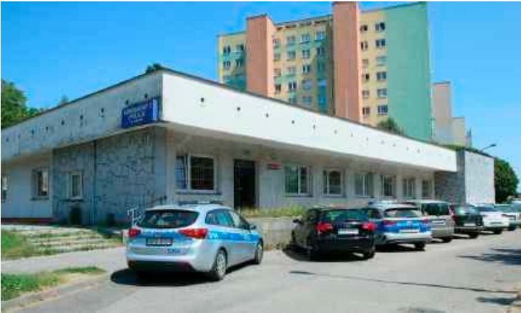
W miejscu obecnego, parterowego budynku stanie nowy, komfortowy komisariat
