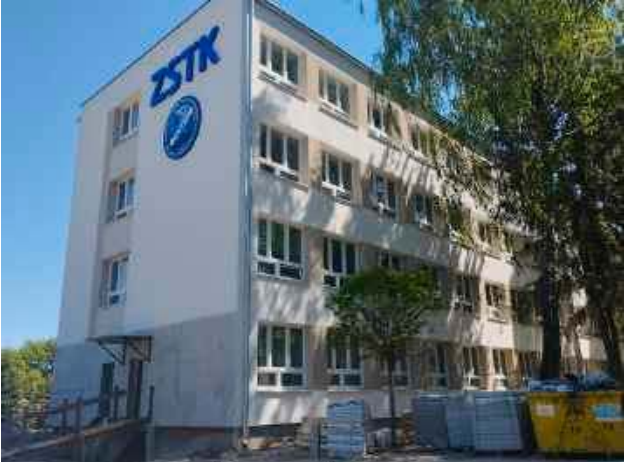
Termomodernizacja szkoły dobiega końca. Do wykonania pozostały jedynie kosmetyczne prace
