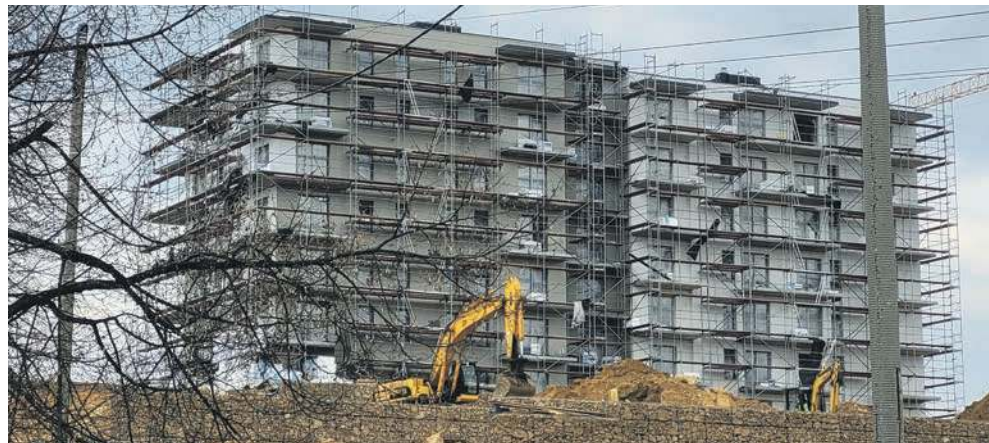
Jeden z budynków powstającego w Trzebini osiedla Vidok
