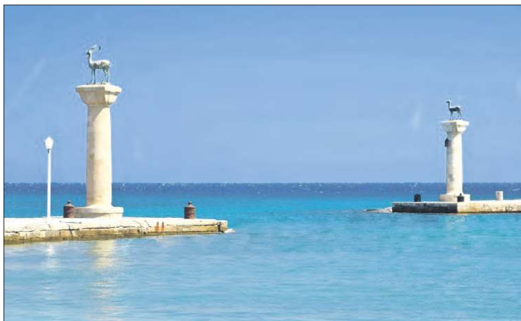
Miejsce w którym stał Kolos Rodyjski
