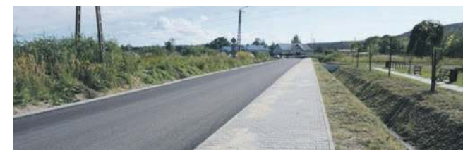
Przebudowa ulicy Dąbrowskiego w Libiążu
