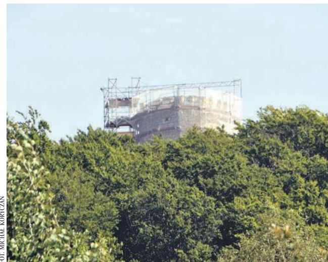
Widok na wieżę zamku Lipowiec
