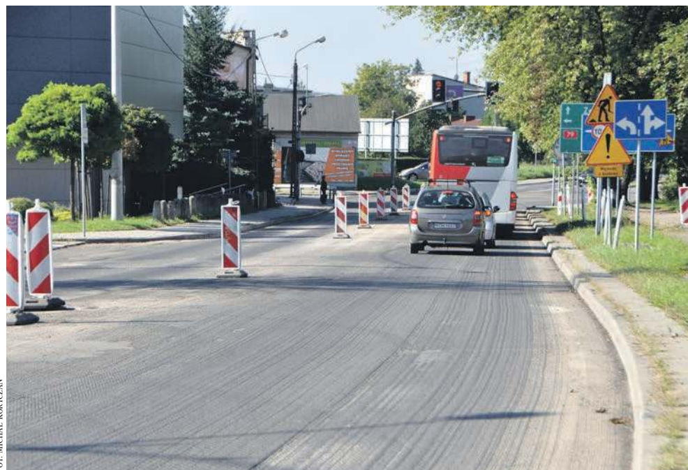
Trwa remont ul. Trzebińskiej w Chrzanowie
