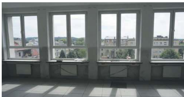
Remont w I LO w Chrzanowie
